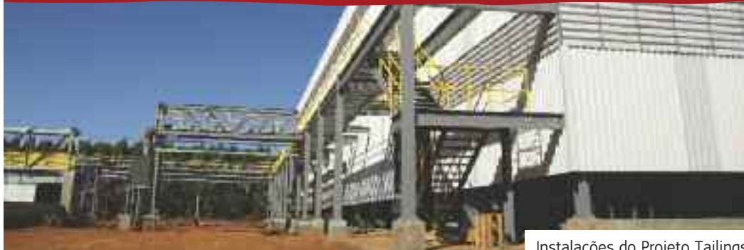
Instalações do Projeto Tailings
